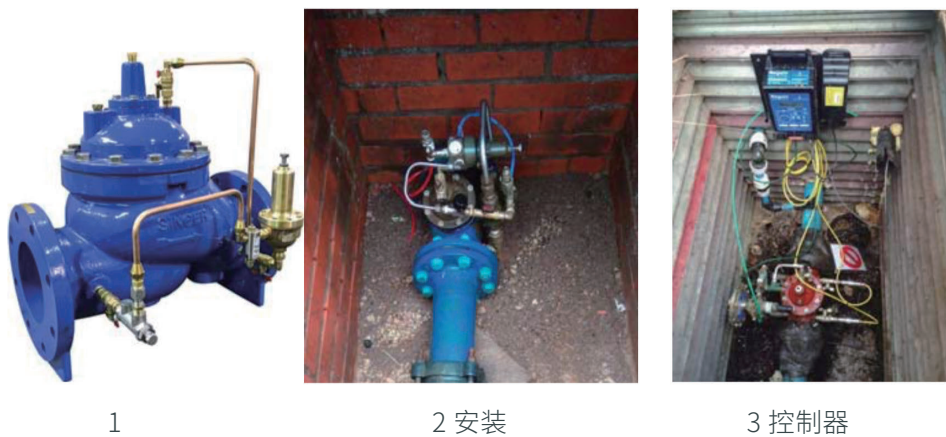
图 18 典型减压阀和安装(来源: Mueller Water Products Inc.(1), K Atkinson(2,3))
